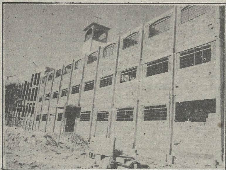
A obra do Colégio Rogacionista está em fase de conclusão.
