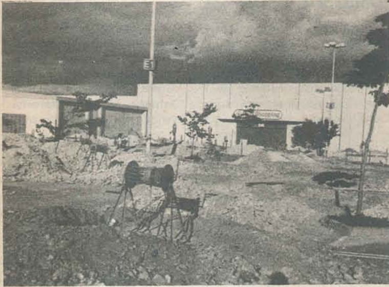
As obras já começaram
