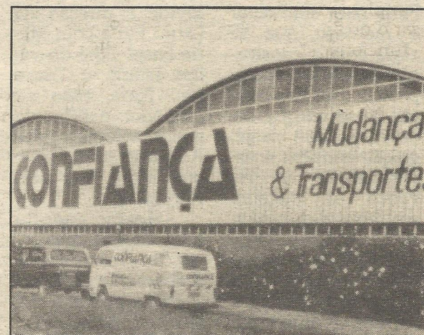
O galpão no Terminal de Cargas
