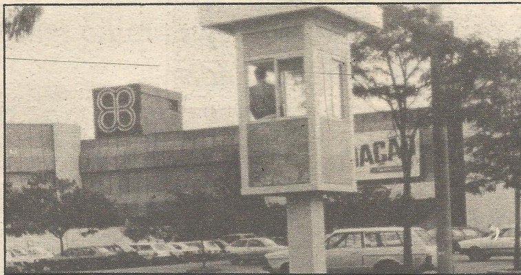
Guaritas permitem controlar o estacionamento
