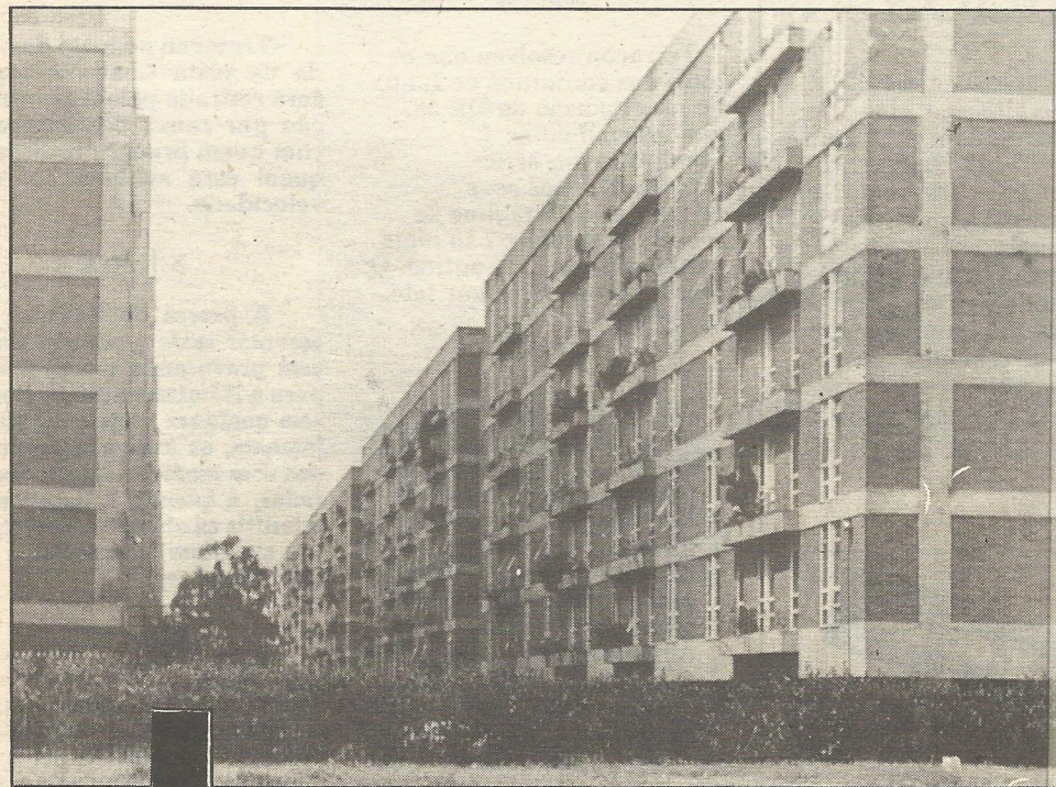
Classe média compra imóvel caro
