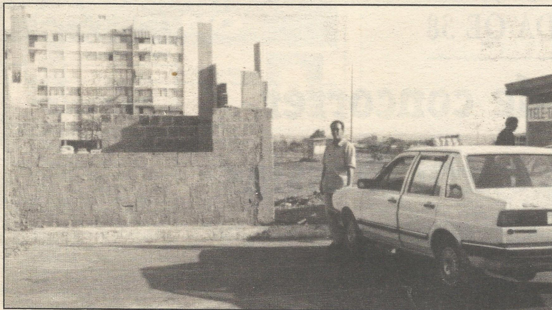
As paredes e a estrutura estavam prontas
