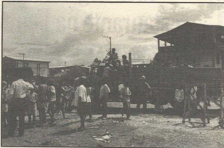
Moradores garantem a construção da escola
