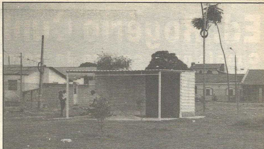
Quiosques do Guará além de irregulares estão sendo ampliados
