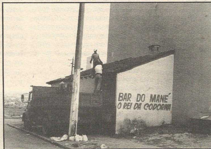
Funcionários da Administração derrubam construção em área pública
