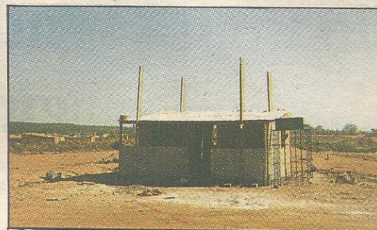
Posto policial foi reconstruído com ajuda dos próprios moradores
