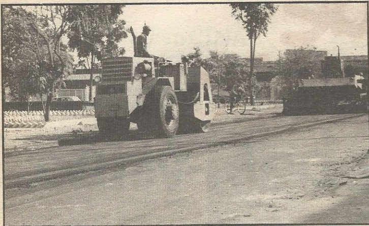
O asfalto do lado par já foi recuperado
