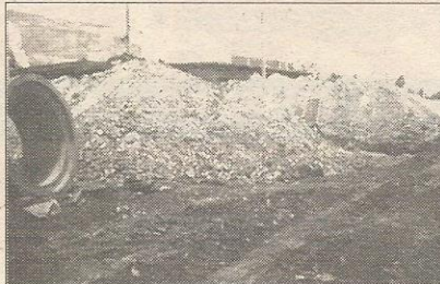
Começam as obras de urbanização
