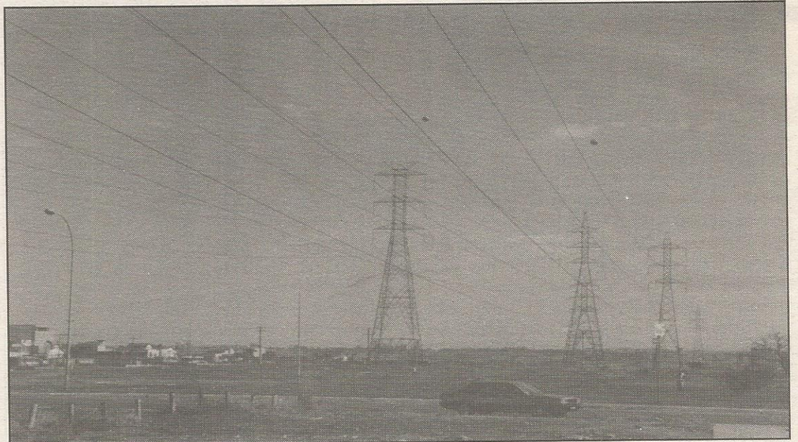
A rede de alta tensão ocupa uma área "morta" entre Guará I e II
