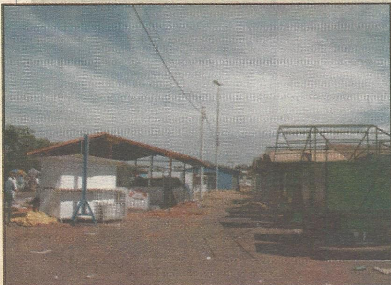
A instalação dos quiosques também está lenta
