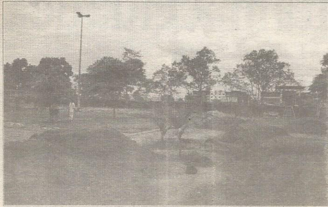
Antigo Vizinhança está sendo reformado para se transformar no Clube do Comerciário
