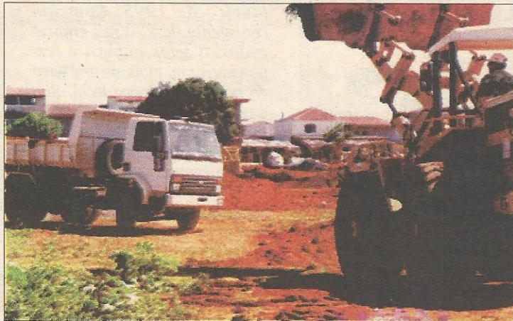
As obras de preparação do terreno do assentamento estão em ritmo acelerado
