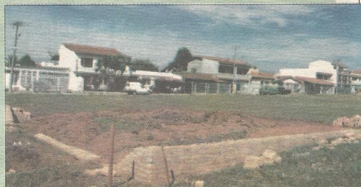
No local, só ficou o início da base e o material de construção
