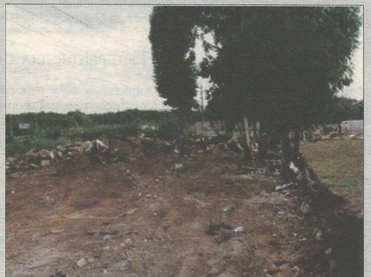
Área está sendo limpa pela Administração Regional
