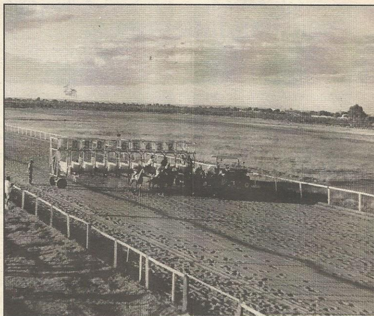
O Jockey passa por nova fase, com obras de ampliação
