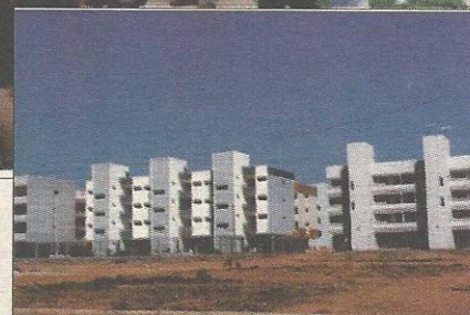
A parte nova (foto maior) e a parte velha se distoam no visual mas problemas são comuns
