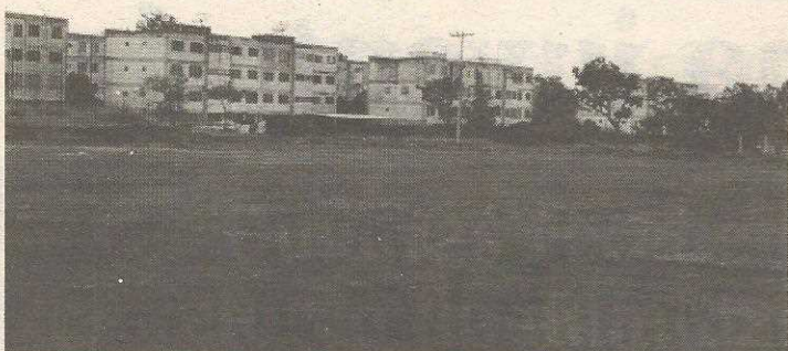
As obras foram iniciadas em fevereiro e ficam prontas em março
