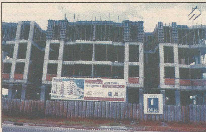
Estgio atual das obras do edifcio Montreal na QI 31 do Guara, ao lado da via central
