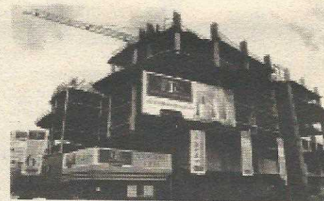
estratégia de obra em março de 2000
