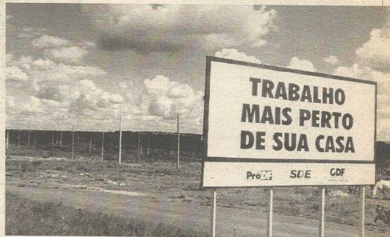
Os postes de energia estão no lugar, mas falta a ligação
