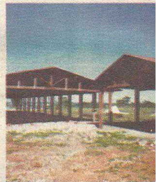
O clube ganha novas piscinas e os outros equipamentos estão sendo recuperados
