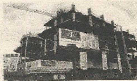
estágio da obra em março de 2000
