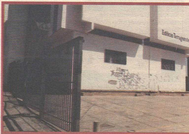
Bloco ficou sem a garagem lateral, que impedia a passagem de pedestres
