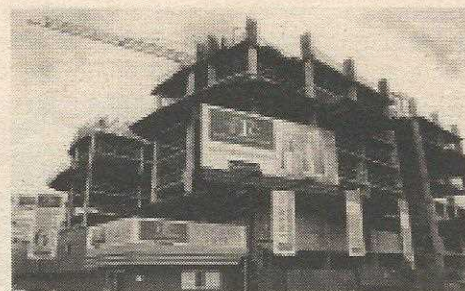
estágio da obra em março de 2000
