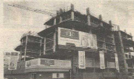
estágio da obra em março de 2000
