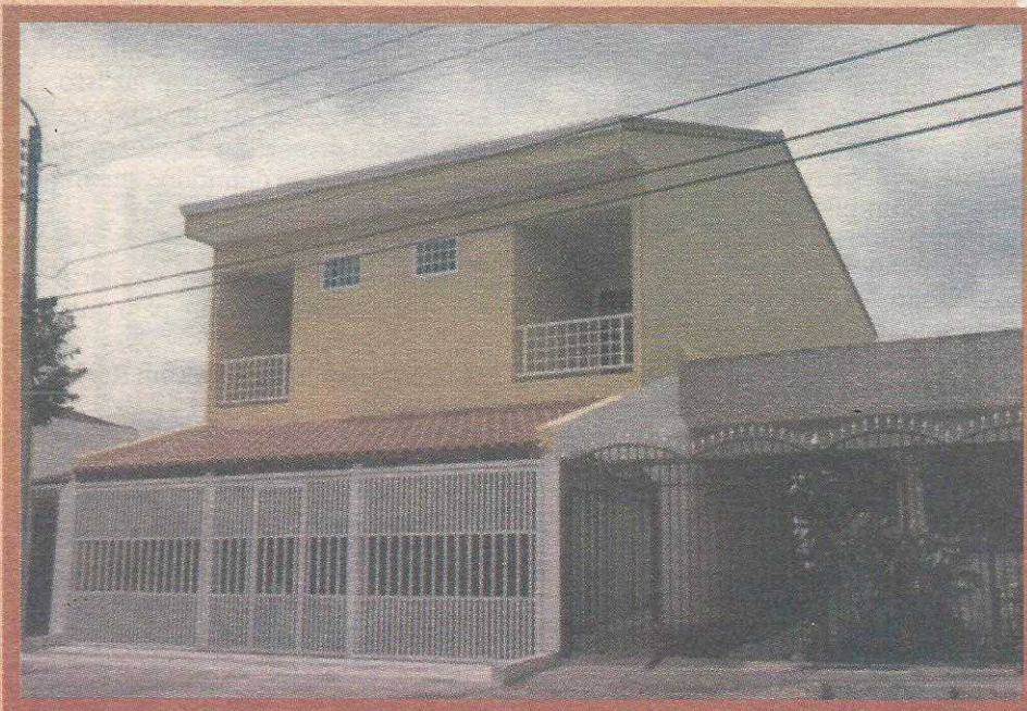
Praticamente todos prédios comerciais e as casas do Guará ocupam área pública
