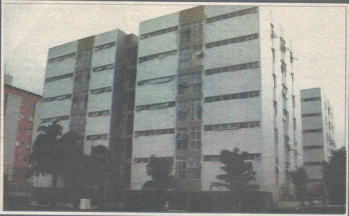
Agora - edifício reformado, mas sem as providências da construtora
