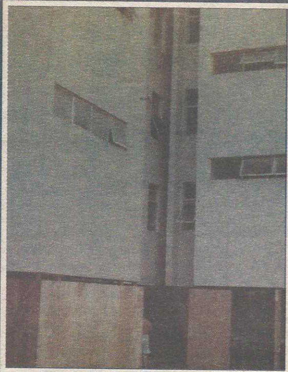
Antes - edifício interditado para reforma, em 93
