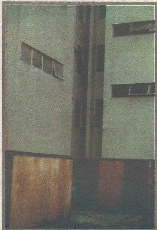
Em 93, por causa das obras e dos riscos, moradores tiveram que se mudar
