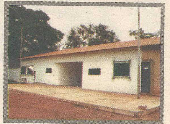
A piscina e o salão de festas estão quase prontos, e a portaria está concluída
