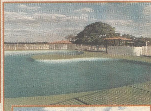
As piscinas receberam fibra no lugar de azulejos e novas casas de máquinas
