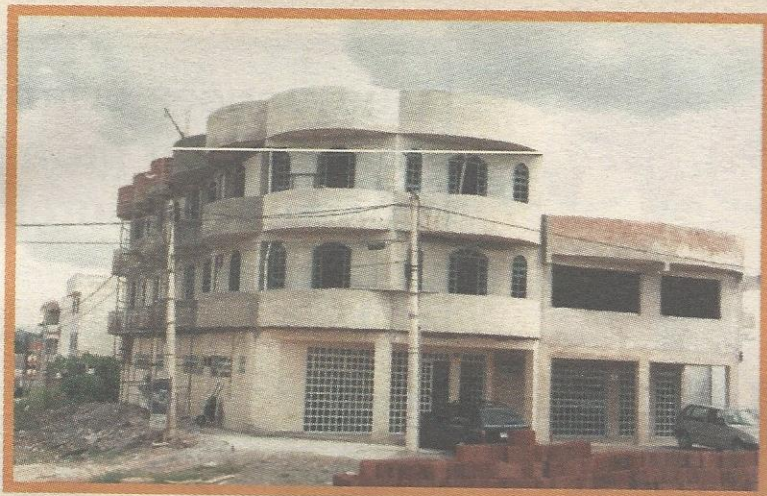
Várias construções estão nitidamente privilegiando a parte residencial, como aconteceu na QE 40. Administração Regional promete agir
