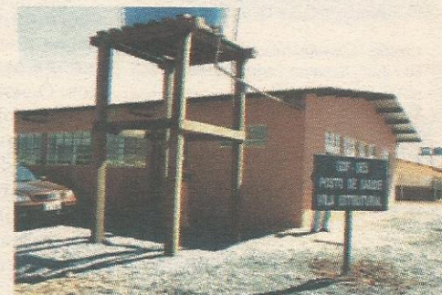
O posto de saúde é outro equipamento entregue pelo governo aos moradores da Estrutural
