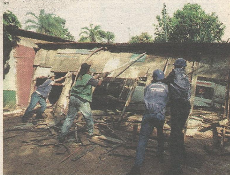
Mesmo sob protesto, operação derrubou cinco casas no Parque
