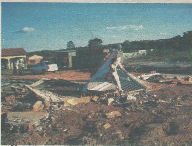
Muros de construções condenadas foram derrubados
