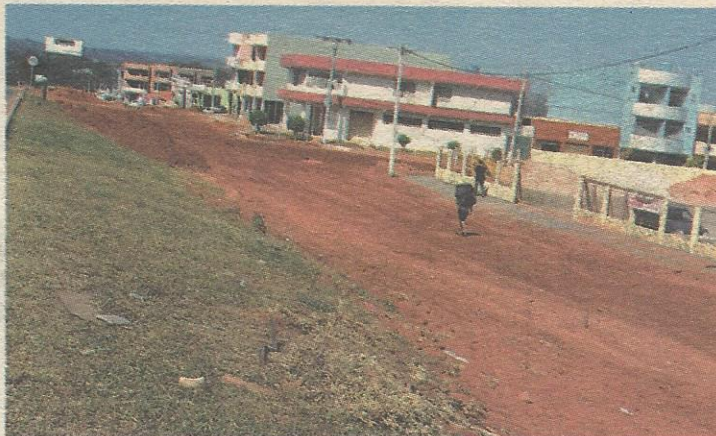
As ruas estão sendo preparadas para receber o asfalto
