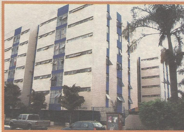
Após a reforma, o Monte Carlo não apresentou mais problemas
