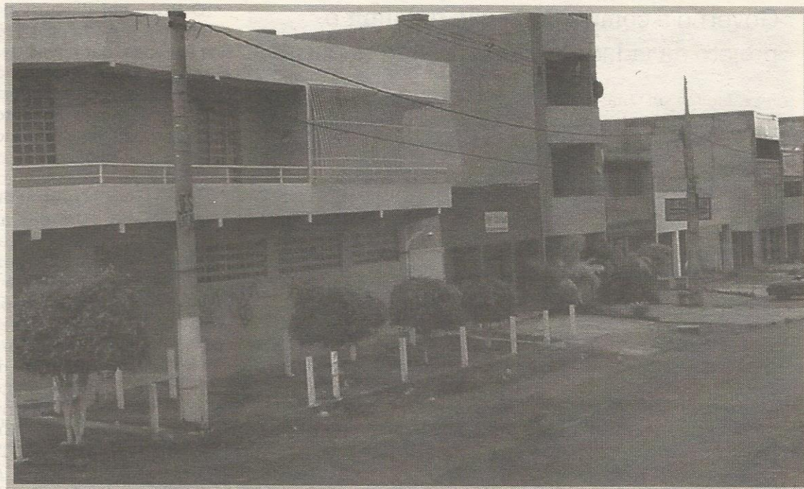
Por enquanto, apenas a metade das empresas está funcionando. O local é um canteiro de obras.
