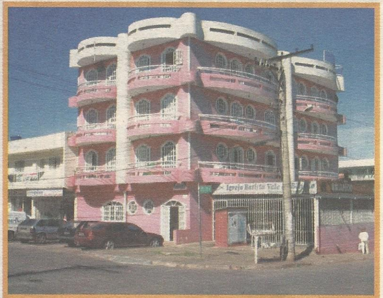
O PDL do Guará terá que resolver, entre outras coisas, a elevação dos edifícios do comércio local e das quadras industriais
