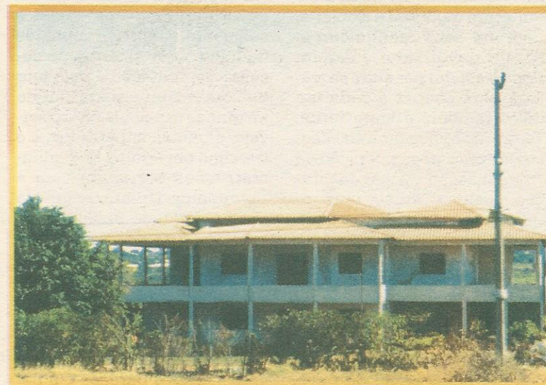
Todas as construções muito próximo ao córrego estão condenadas
