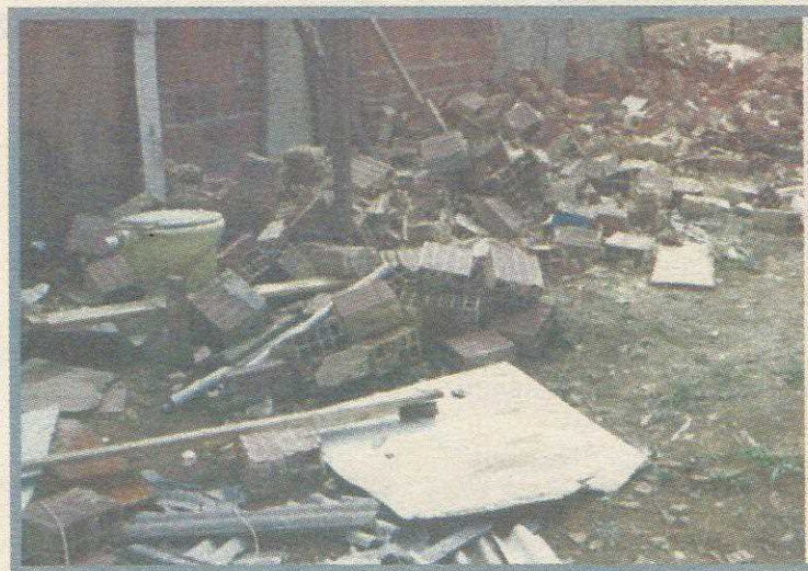
Casas e muros já haviam sido demolidos em 2004
