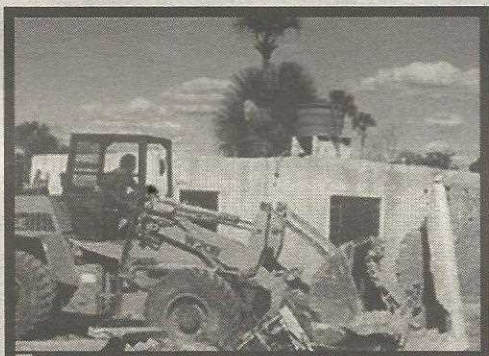
Estão sendo removidas construções em áreas ambientais
