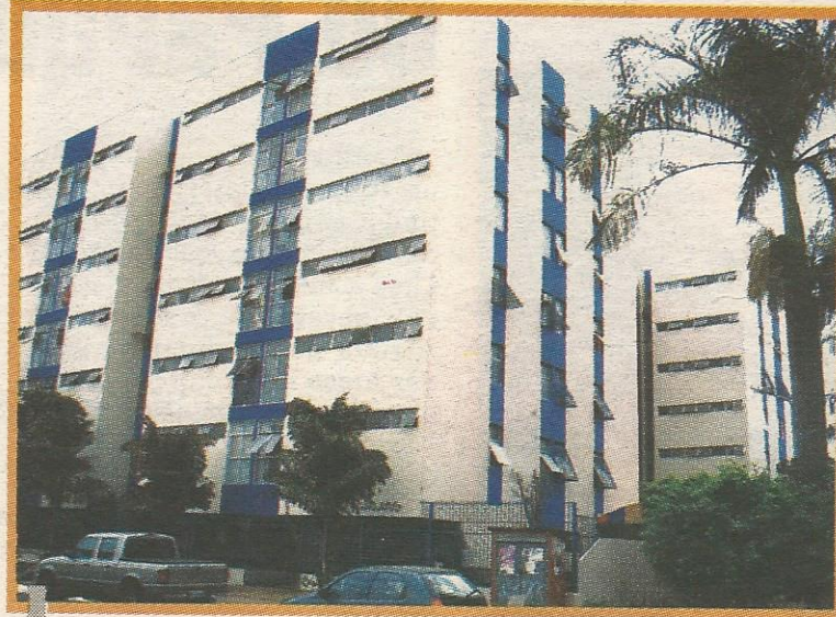
Indenização será dividida entre os 120 proprietários e moradores da época que ocorreram os problemas na estrutura
