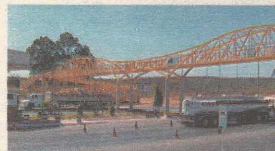
Sobradinho: construção de passarela na estrada de Sobradinho, subida do Colorado.
