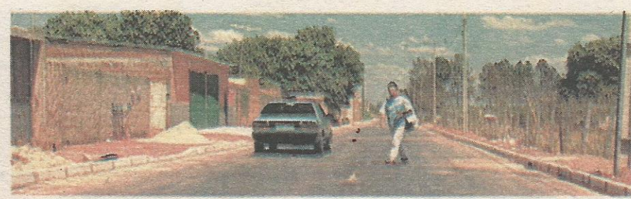
Brazlândia: asfaltamento da via de Contorno do Incra 8.
