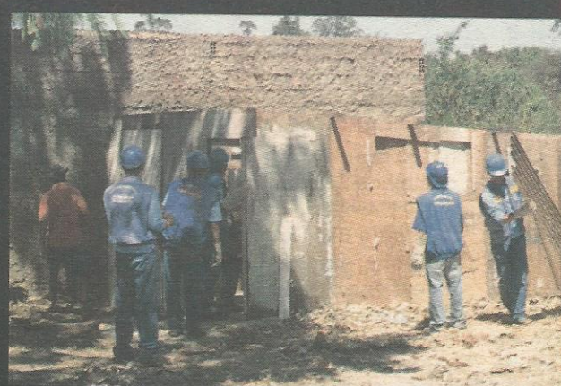
e a casa foi demolida
