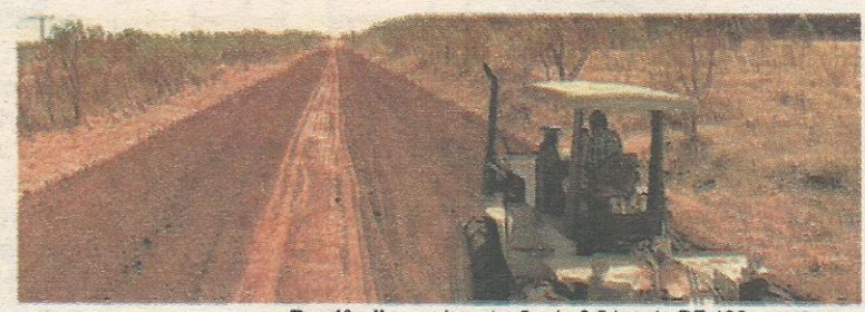
Brazlândia: pavimentação de 8,5 km da DF 430.
