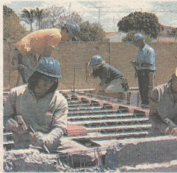
Gama: reforma e ampliação do Centro de Saúde nº 4.
