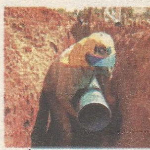
Águas Claras: redes de água e esgoto no Areal.
