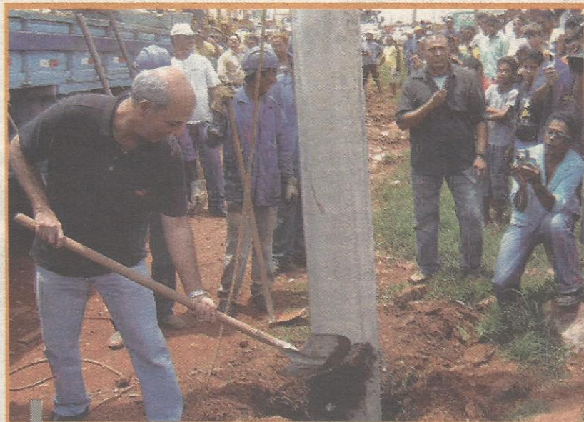
Arruda dá o início simbólico das obras na Estrutural
