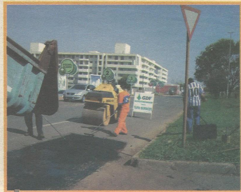
Serviço evita que asfalto se deteriore quando as chuvas se intensificarem
