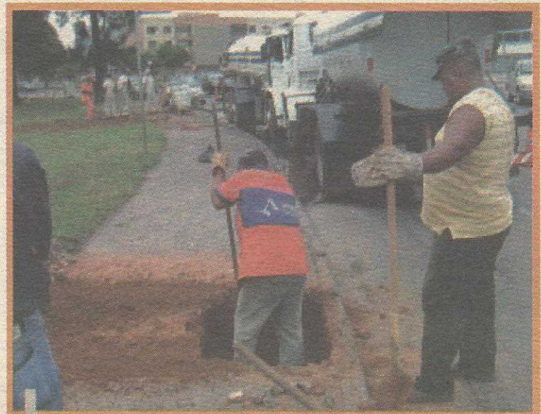
Obra cria escoamentos para as águas pluviais nos pontos onde ocorriam inundações
