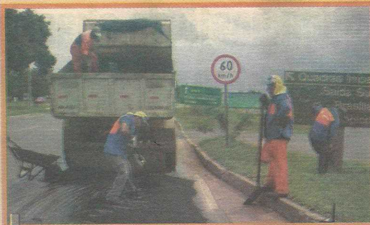
Operação recuperou o asfalto que estava danificado
