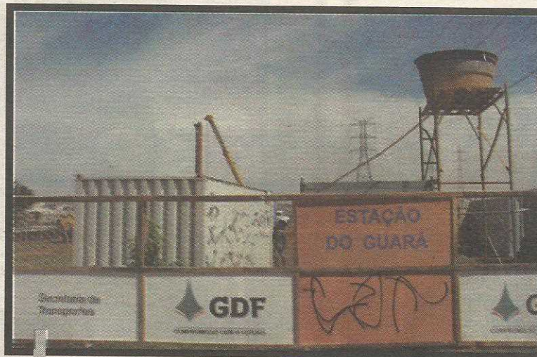
Instalação do canteiro indica início da construção
