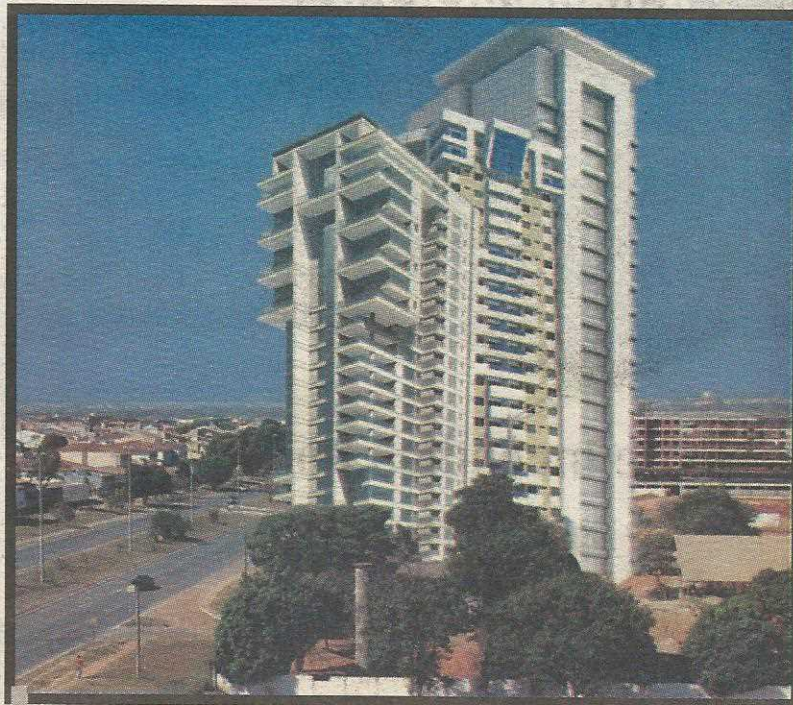
Fotomontagem mostra como ficará a orla do Guará II, pelo lado par, após a construção das torres
