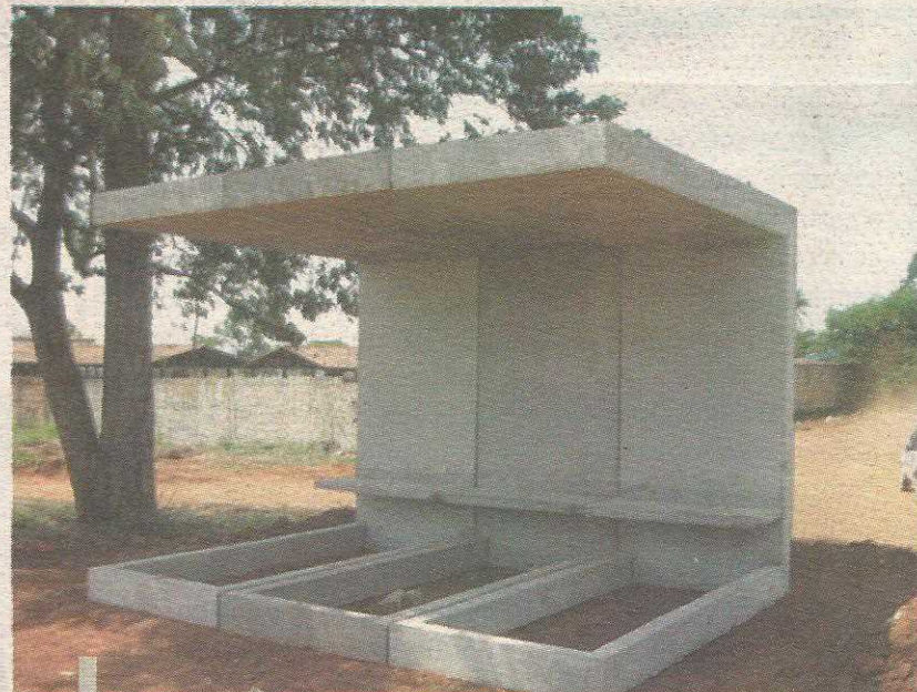
Novos abrigos são em concreto pré-moldado, mais resistentes
