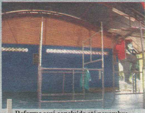
Reforma será concluída até novembro
