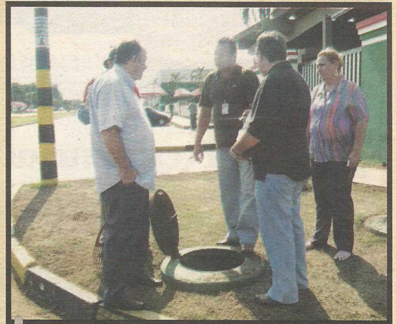
O administrador Joel Alves (esquerda), técnicos da Caesb e a prefeita Ana Paula Mendes vistoriando as instalações pluviais
