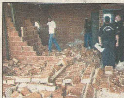
fiscais da Agefis derrubam dois pavimentos de uma obra irregular
