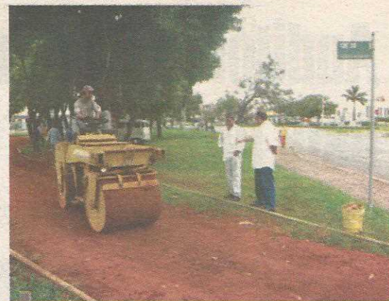
Administrador Joel Alves acompanha as obras das novas calçadas
