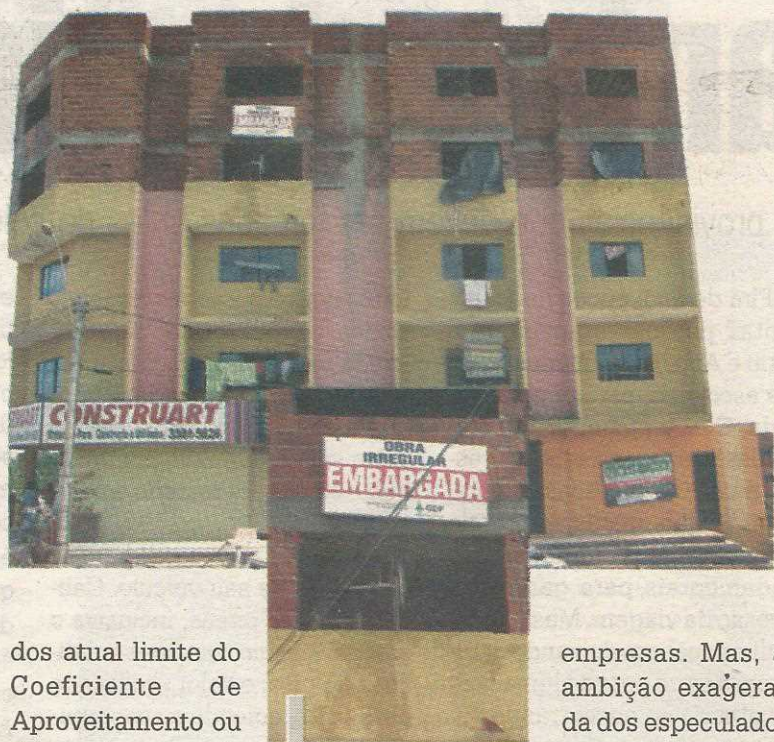
Seis edifícios já foram embargados
