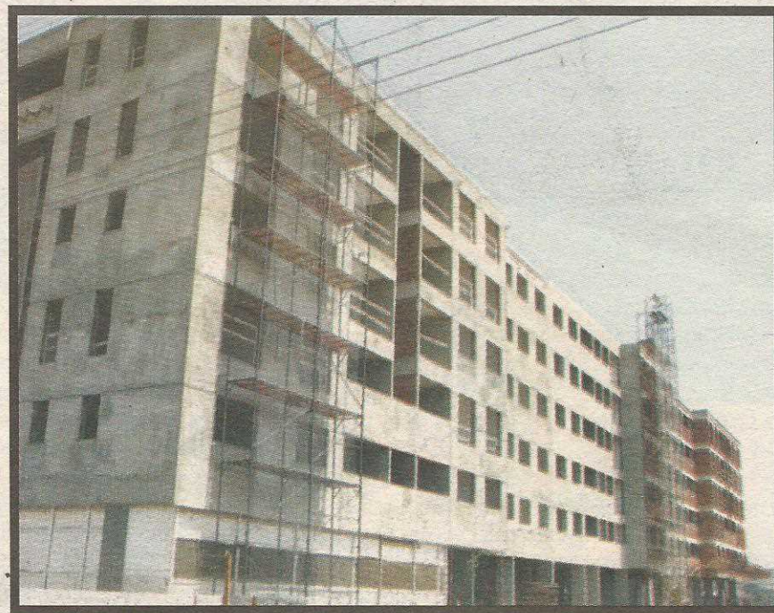
A liberaao dos alvars retoma o ritmo das obras na orla do Guar II, interrompido desde setembro
